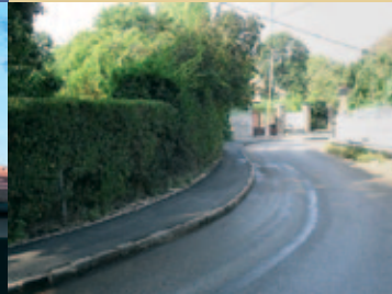
Rákóczi utcai járda- felújítás
