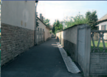
Járdaépítés a Mozi közben
